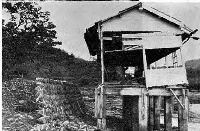
陸上に全部打ち揚げ られ筏、建物共に 全滅に近い贅のN養殖場
