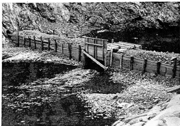
(2) 堰堤及び樋門
